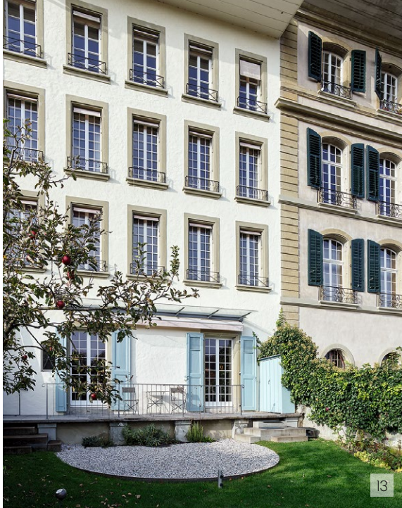
13 Südansicht: Beide Zimmer im unteren Geschoss haben nun direkten Zugang zum Garten, der hoch über dem Mattequartier über eine sensationelle Weitsicht verfügt.
