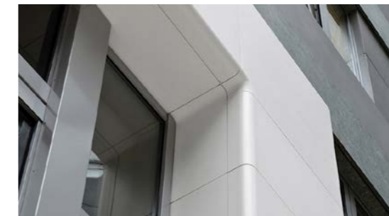
Dass hier HIMACS zum Einsatz kam, ist der Tatsache zu verdanken, dass man mit diesem Material perfekt „weiche“ Formen, z.B. abgerundete Ecken gestalten kann.
