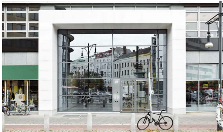
Tagsüber verbirgt sich die Lichttechnik unsichtbar und geschützt hinter der soliden HIMACS-Oberfläche.
